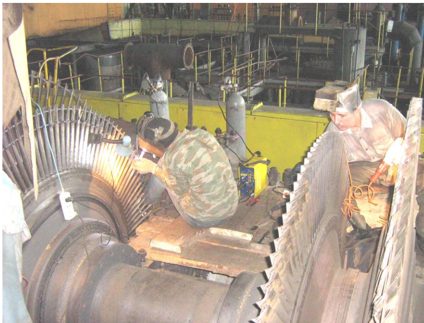
Рисунок 1. Восстановление лопаток РНД на роторе турбины
